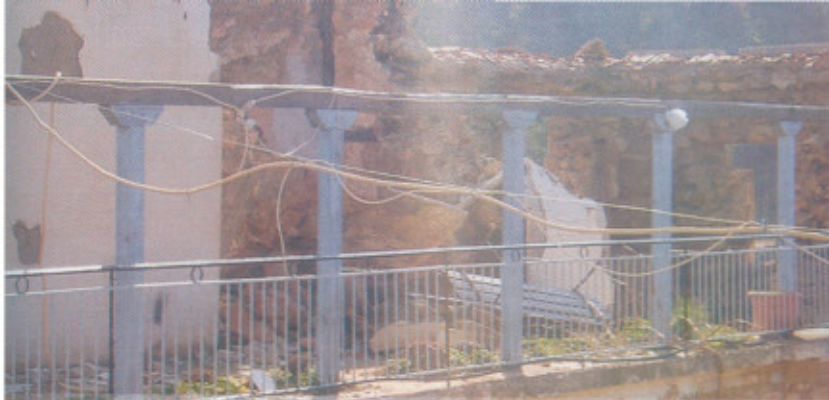
Νότια Πτέρυγα, κατεστραμμένη απ' την πυρκαγιά και τις άκραίες καιρικές συνθήκες.
